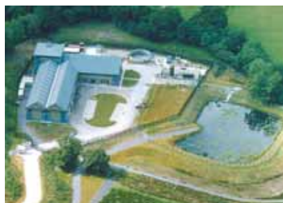
Пример труднодоступной насосной станции
